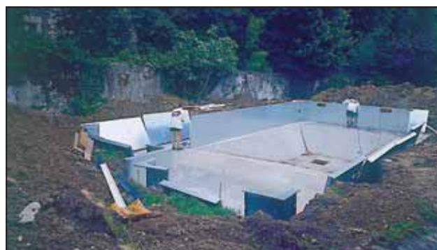
4. Pose de la structure Pooline. Mise en place des jambes de force et des pièces à sceller
